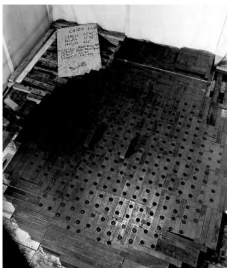
Pile 1, de eerste kernreactor, 1942, Chicago. 330 ton grafiet en 50 ton natuurlijk uranium.
